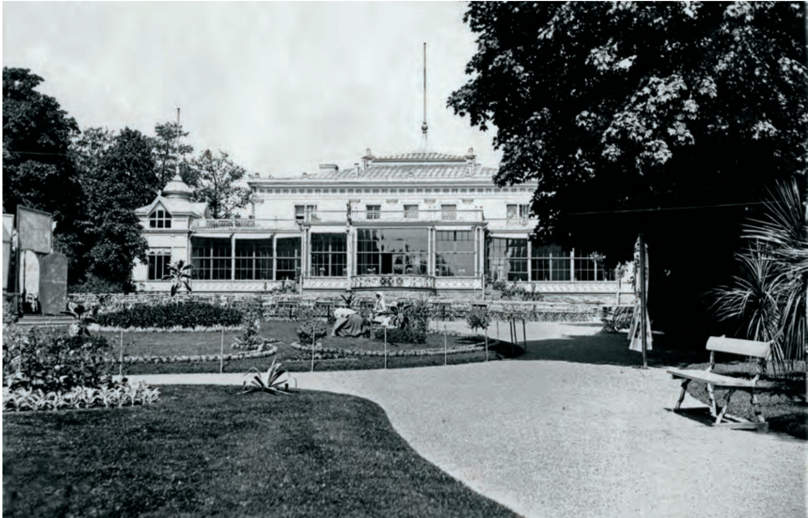
Kaivohuoneen edustan Teppich-istutus 1900-luvun alusta. HKM.
